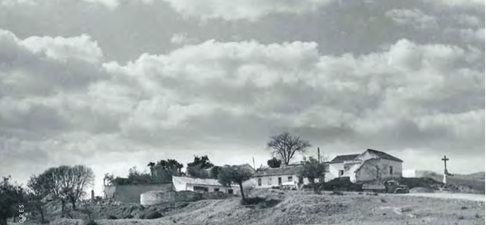
Figura 2. Construcciones rurales (ca. 1940), hoy no conservadas, que estaban contiguas a la antigua fonda e integraban viviendas de peones, cuadra, lavadero, cochiguera y acceso a la cueva. Fuente: Ladislao Rodríguez Benítez, «Ladis» (fotogr.). Fototeca del Archivo Municipal de Córdoba (FAMC).
