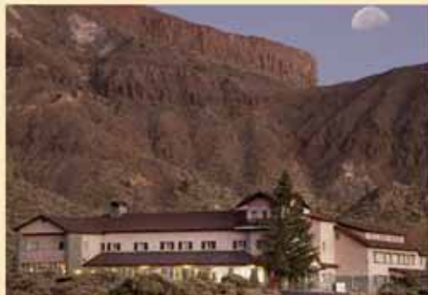
Modernización Parador Cañadas del Teide
