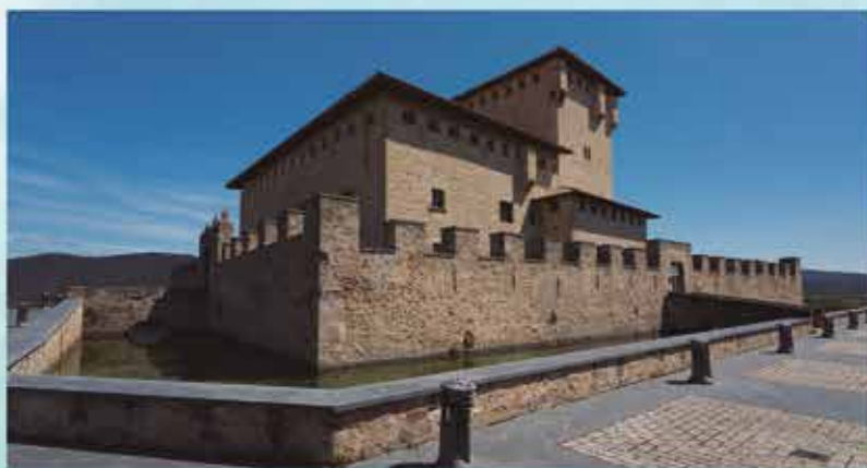
Torre de los Varona (exterior)
