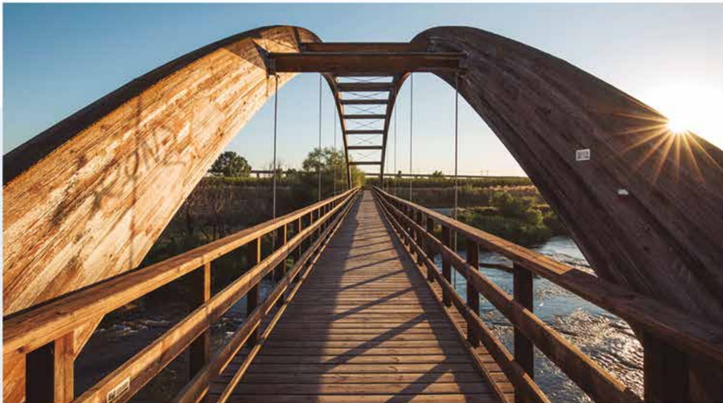
Pasarela del Tófol en el rio Segre
