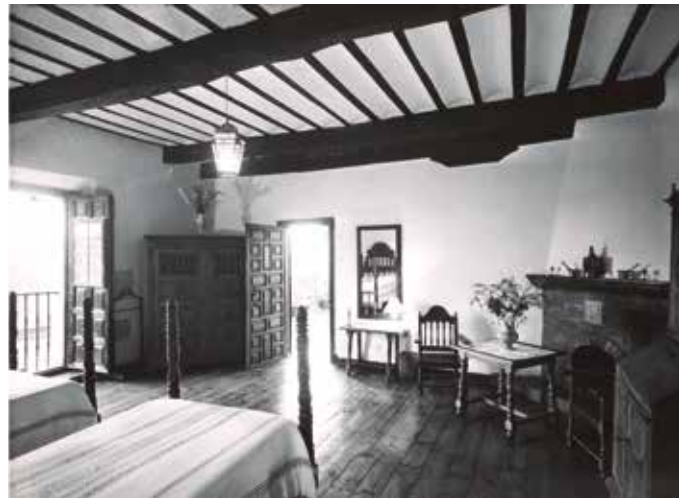
Habitación principal del parador (c. 1966), con terraza abierta ex novo en la reforma de los años cuarenta. Fuente: CDTE, sign. 39S0275.
