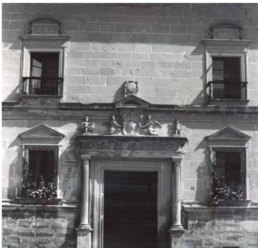
Palacio del Deán Ortega (actual parador). El escudo del marqués de Donadío sobre la portada, su último propietario noble, sustituyó el original de los Ortega, en el siglo XIX. Fuente: CDTE.
